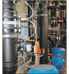
Das komplette Filtersystem ist ausgetauscht worden.
